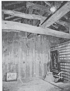
写真 17.土蔵二階内部
